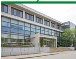
総合科学部3号館
