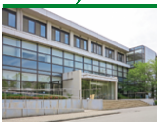
総合科学部3号館
