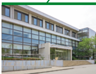
総合科学部3号館
